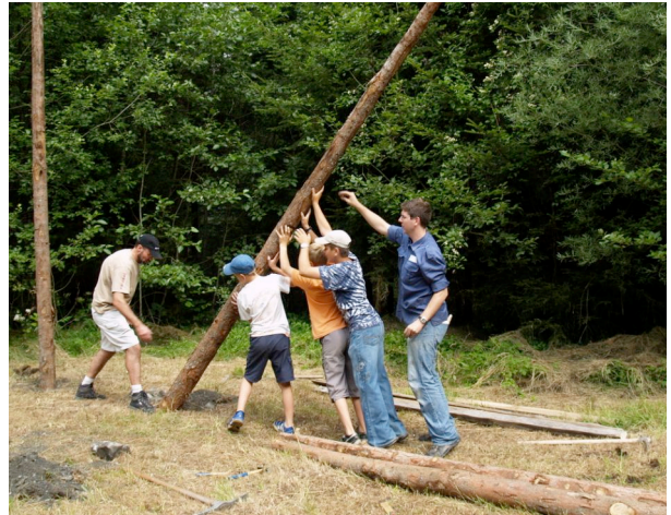
Stellen der Pfosten für den Turm
