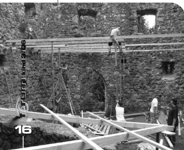
Aufrichtung des Burgtors
